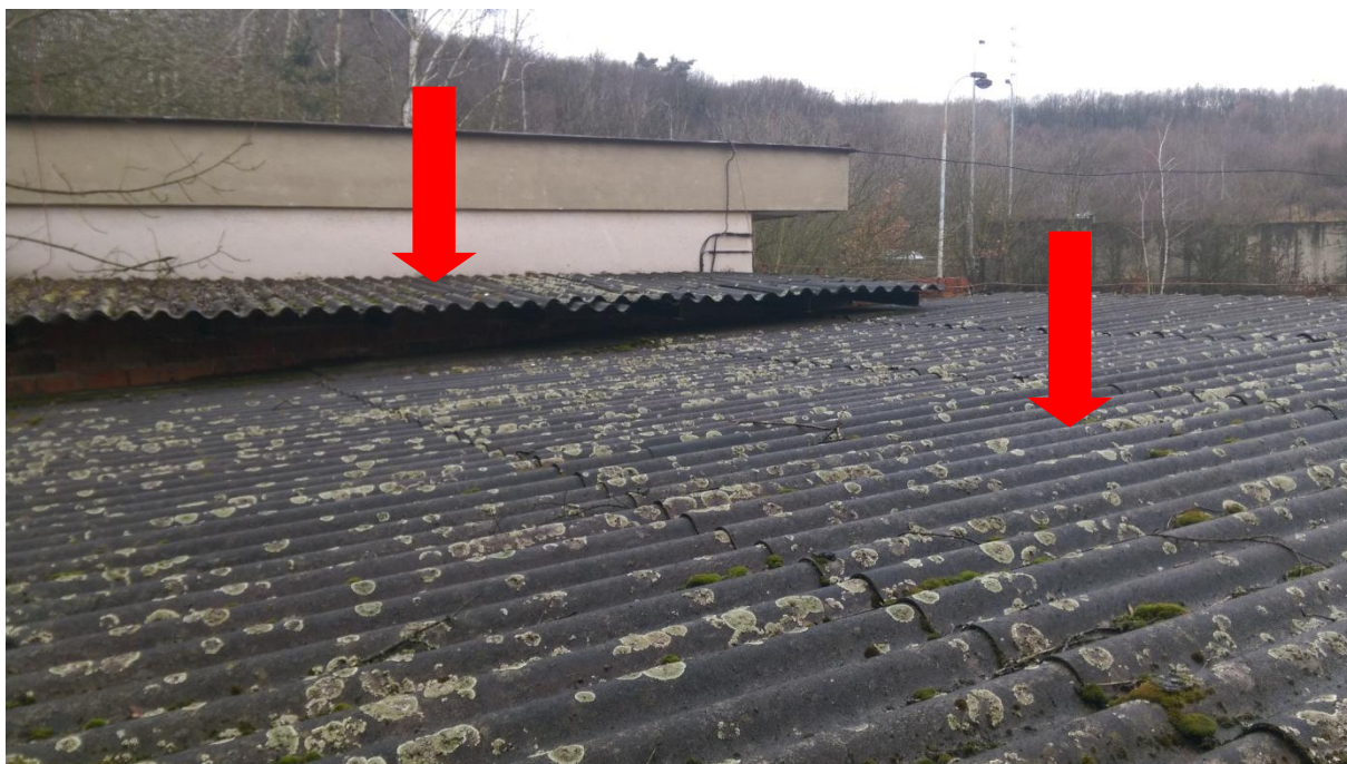
Obr. 2. Sklad 1, dílna údržby, azbestocementové vlnité desky ETERNIT jako střešní krytina. Pohled shora.
