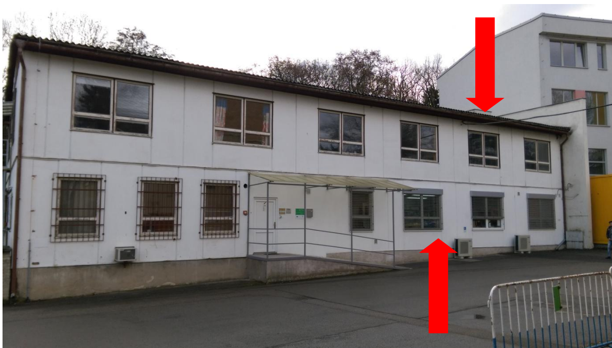
Obr. 6. Budova "E", azbestocementové vlnité desky ETERNIT jako střešní krytina, azbestové desky na vnější straně obvodového pláště.
