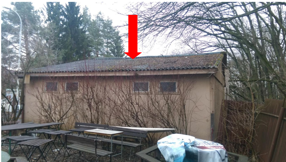
Obr. 5. Sklad 2, azbestocementové vlnité desky ETERNIT jako střešní krytina.
