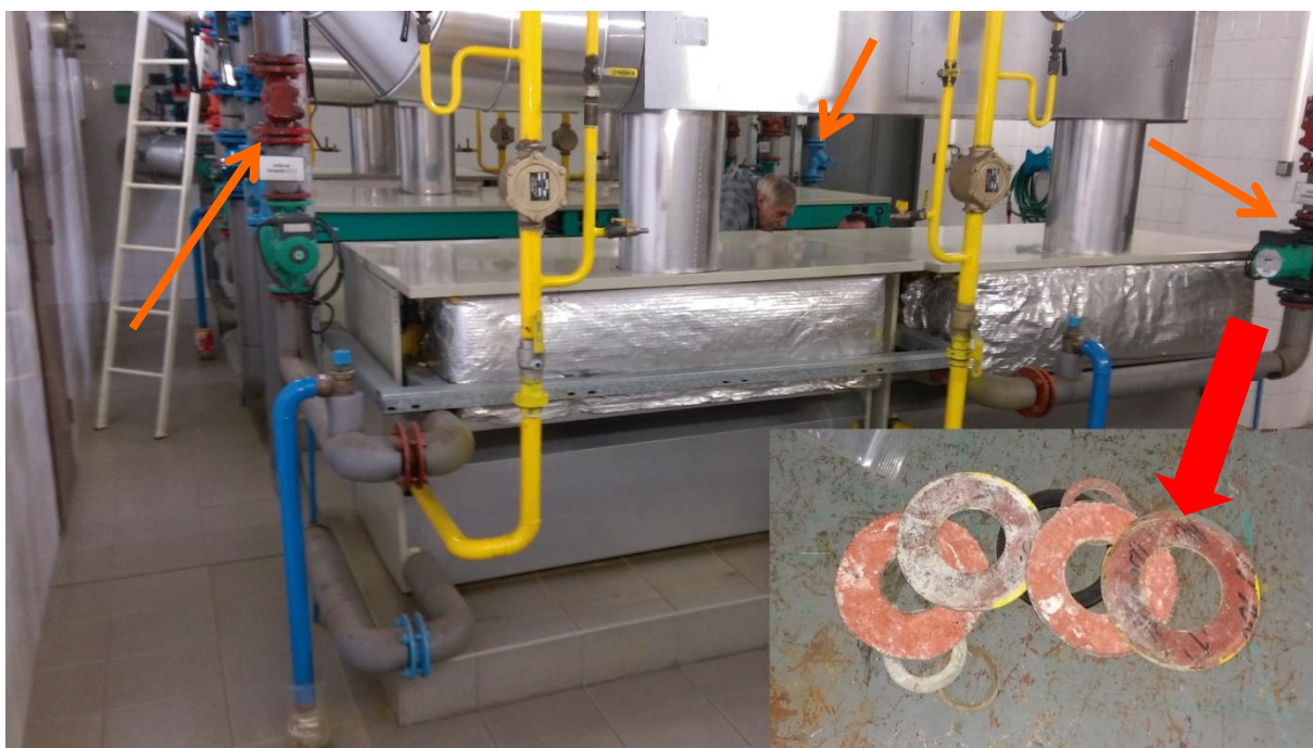
Obr. 8. Kotelna, strojovna, technologické vybavení s přírubovými spoji s plochým těsněním. Stůl údržby. Azbestová plochá těsnění s nápisem Azbestos.
