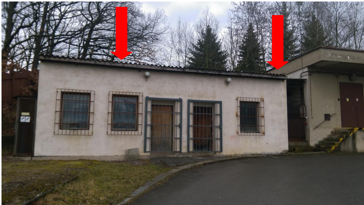
Obr. 1. Sklad 1, dílna údržby, azbestocementové vlnité desky ETERNIT jako střešní krytina.
