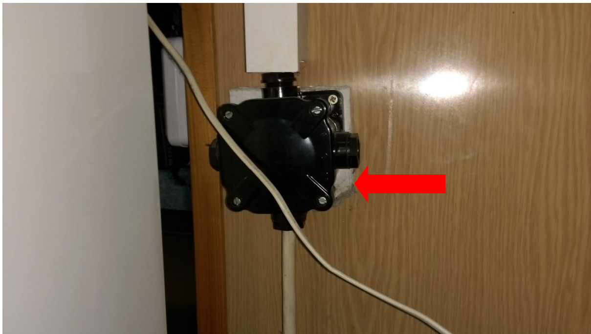
Obr. 7. Budova "E", 1.Np, laboratoř. Azbestová podkladová destička pod elektroinstalací.
